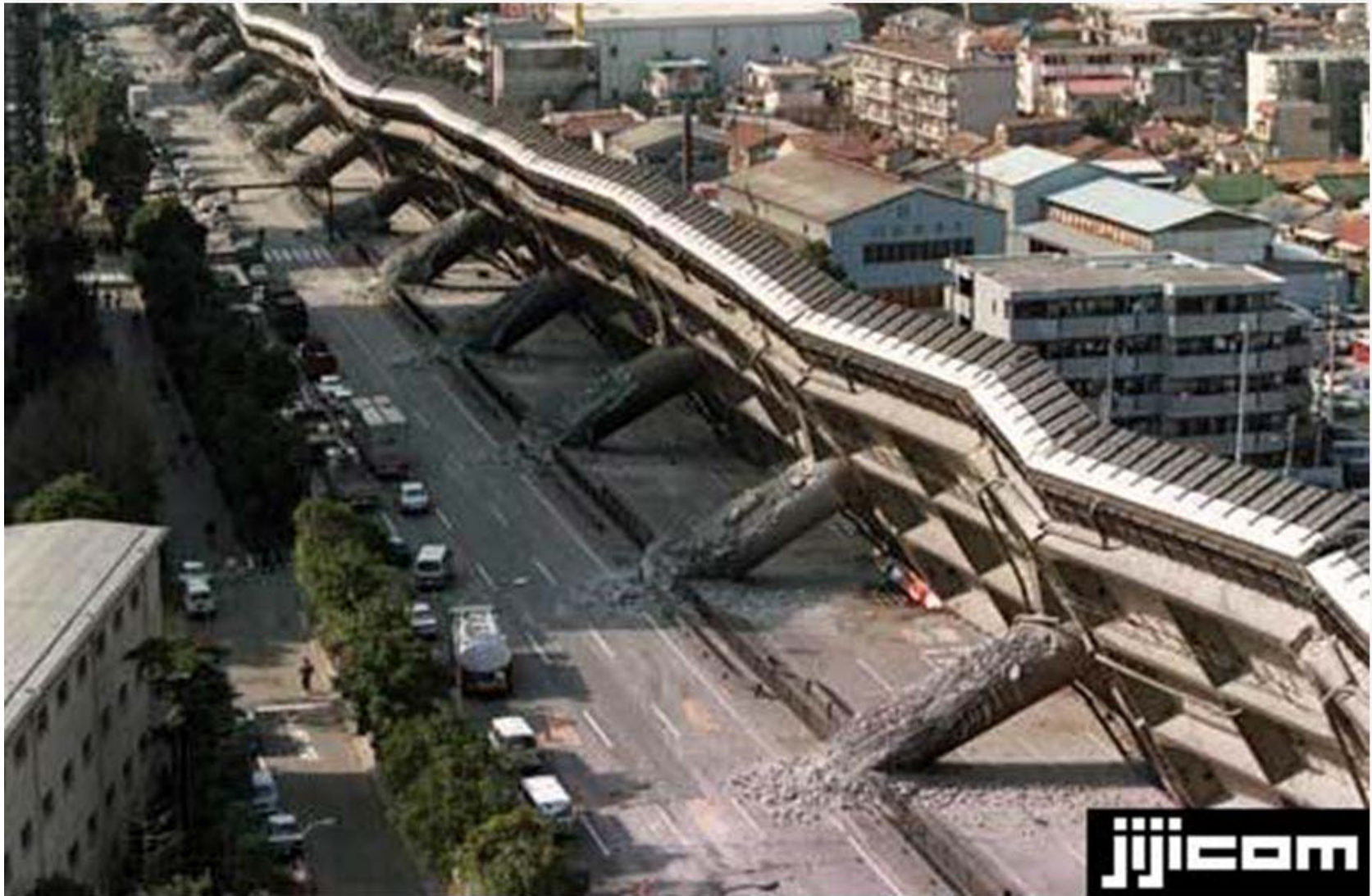
阪神大震災で倒壊した阪神高速道路
