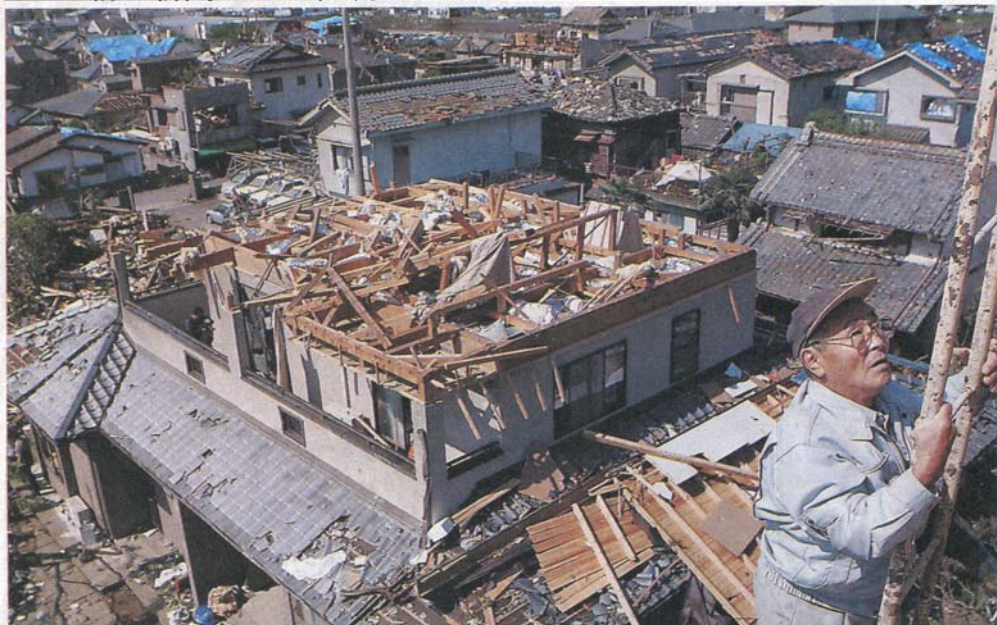
竜巻で屋根が吹き飛ばされた住宅。近隣でも被害の程度に差がある＝7日午前8時51分、茨城県つくば市北条、山本裕之撮影
