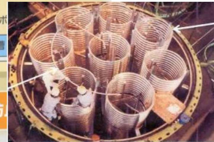
写真2 貯槽タンクの冷却パイプ
