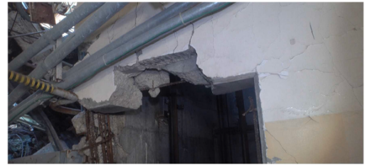
2021年11月26日原子力規制庁撮影 図24 エレベータ室入口付近(1号機原子炉建屋4階)
