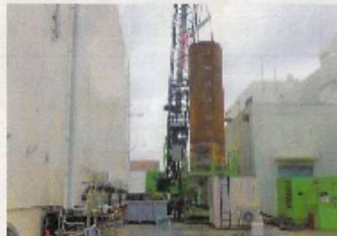
基礎杭の打設状況 (押し波)
