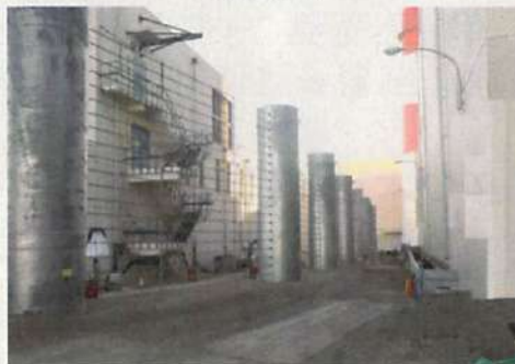
津波漂流物防護柵(押し波)の 設置状況(令和5年12月)
