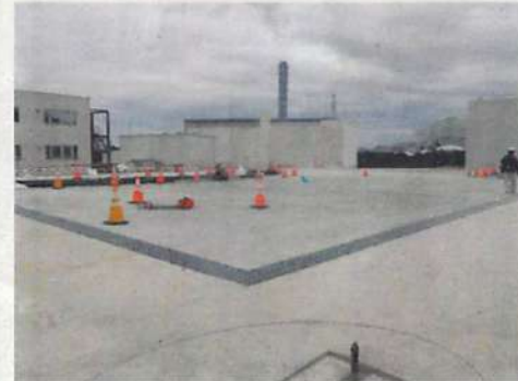
移動式発電機等設置箇所
