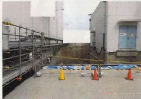
地盤改良状況 (押し波)
