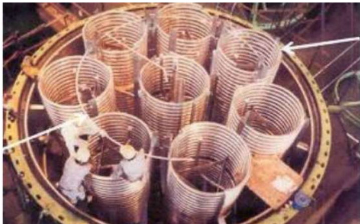
120m 3 貯槽 直径約6.8m 高さ約4.8m 板厚22mm 材質 ステン レス316ULC
