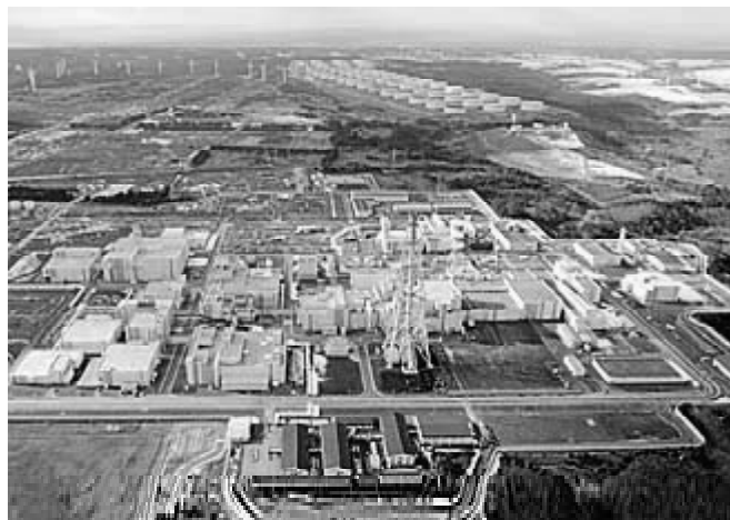
六ヶ所再処理工場
