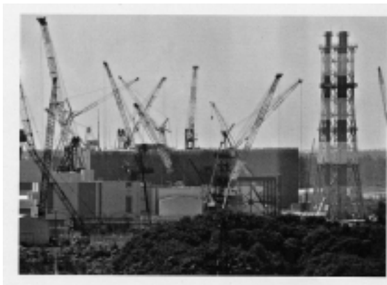
建設進む六ヶ所再処理工場
