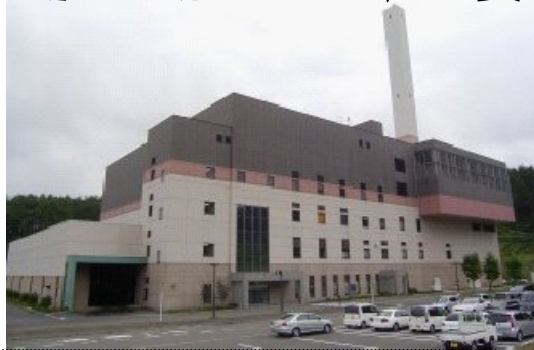
盛岡市クリーンセンター焼却炉
