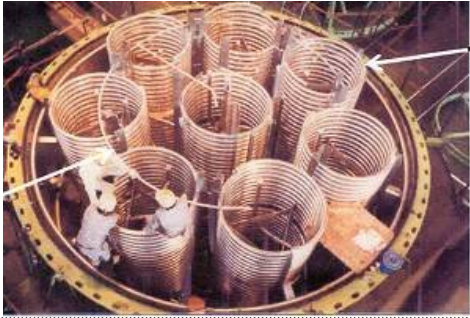
写真2 貯槽タンクの冷却パイプ (第2回ヒヤリング資料17頁)
