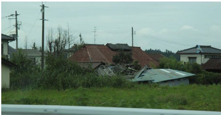
上 双葉町の倒壊寸前の家屋。繁茂する雑木、剥がれた落ちた瓦。
